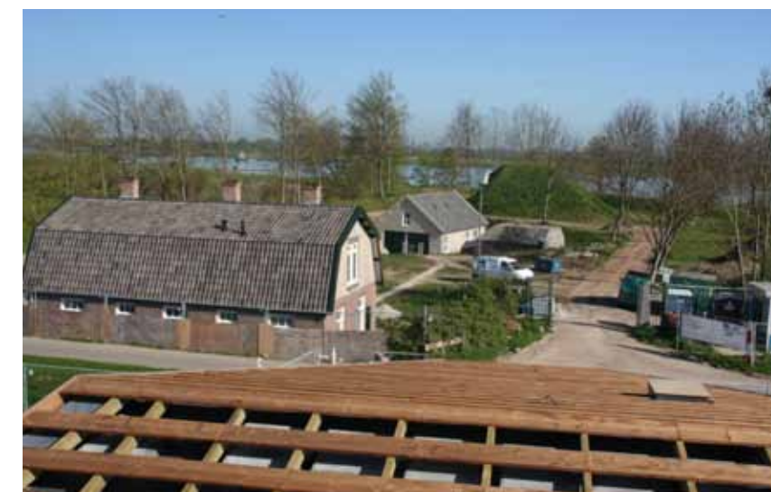
Uitzicht over de Lek vanaf dak Forthuis
